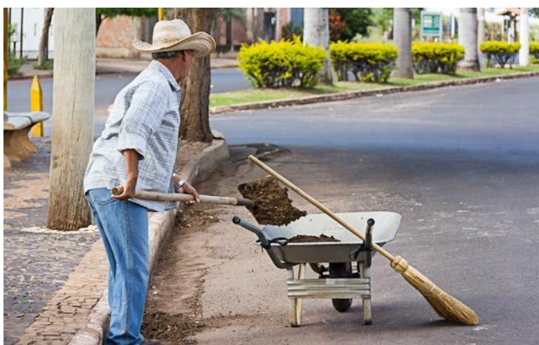
Figura 17 – Raspagem sendo realizada na zona urbana de Paraíso, SP.
