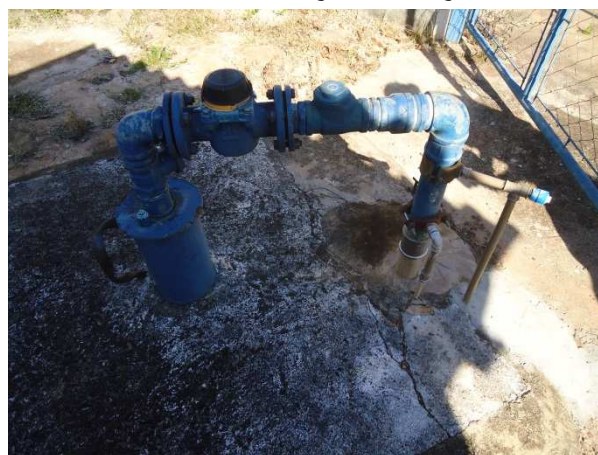
Foto 3.4 - Identificação do Poço: P-04
