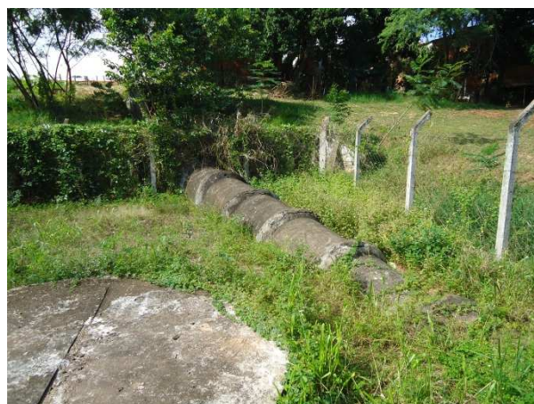
Foto 3.34 – Tubulação que destina a água pluvial para o Córrego das Pedras
