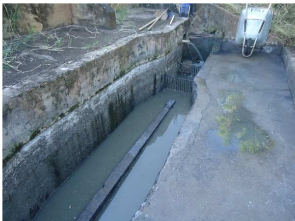
Foto 3.22 – EEE1 - Tratamento Preliminar: Gradeamento e Caixa de Areia
