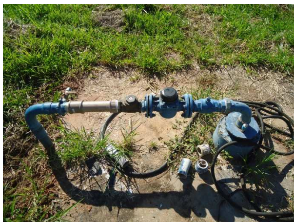
Foto 3.7 - Identificação do Poço: P-07
