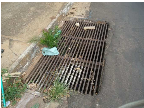
Foto 3.31 – Boca de lobo
