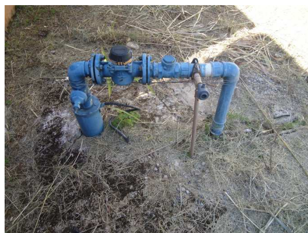
Foto 3.8 - Identificação do Poço: P-08
