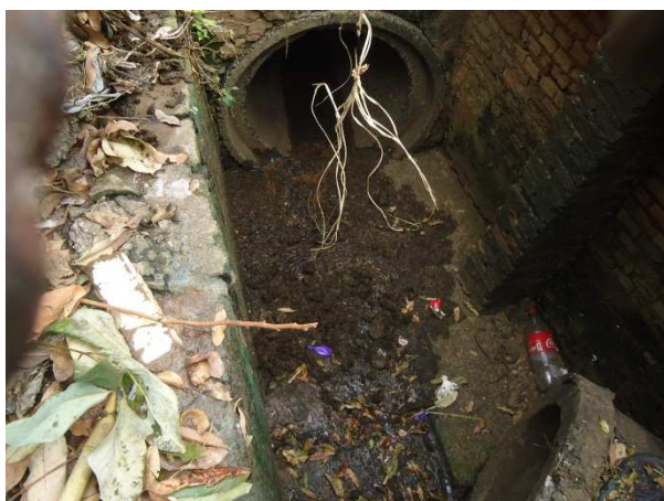
Foto 3.33 – Rede receptora da água de Boca de lobo
