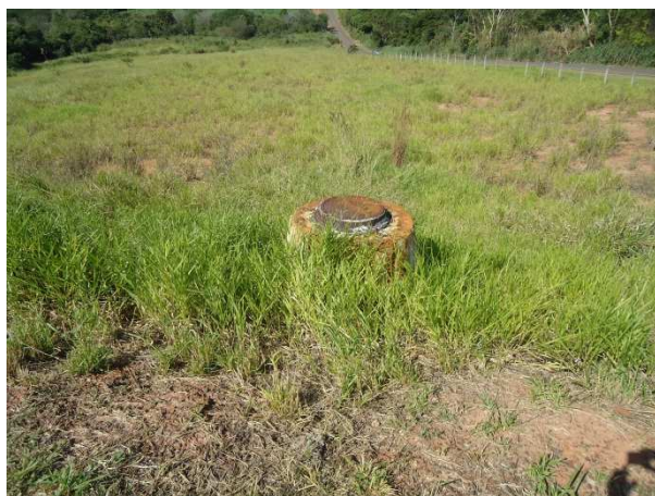
Foto 3.30 – Emissário Final da Lagoa Anaeróbia
