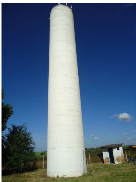
Foto 3.18 – Reservatório 03 (Sist. Creche)
