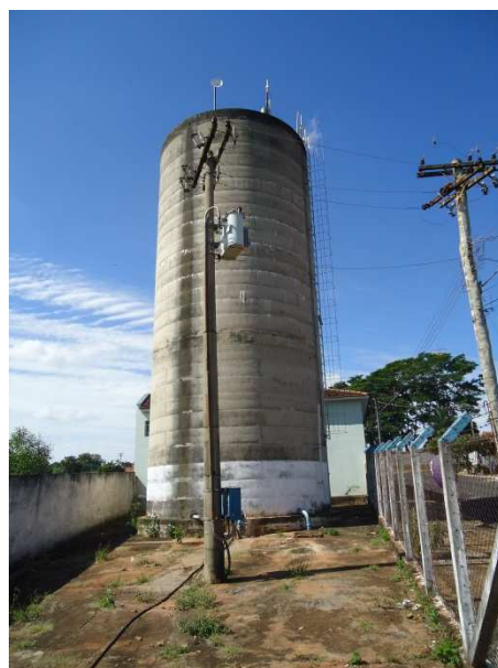
Foto 3.21 – Reservatório 06 (Sist. COHAB)
