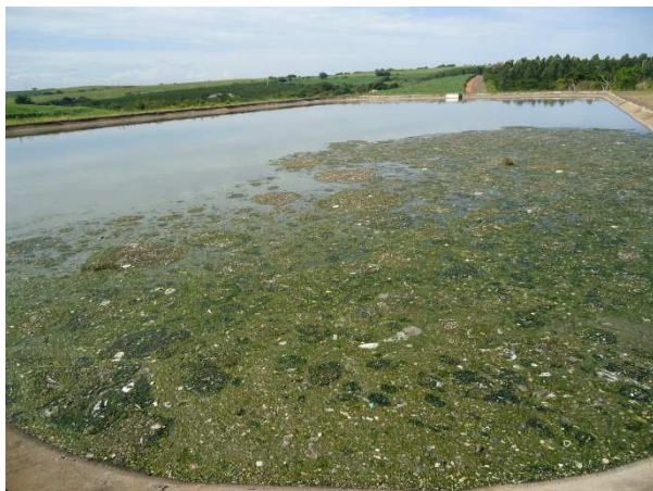
Foto 3.28 – Sobrenadante na Lagoa Anaeróbia
