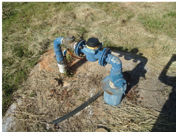
Foto 3.6 - Identificação do Poço: P-06
