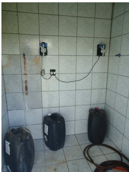
Foto 3.14- Unidade de Fluoretação e Cloração com bomba dosadora – Sistema Jd Beatriz – P7
