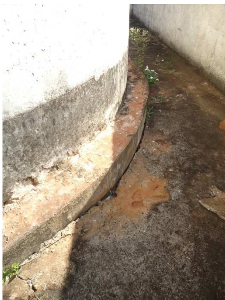
Foto 6.3 – R-06 – Rebaixamento da base
