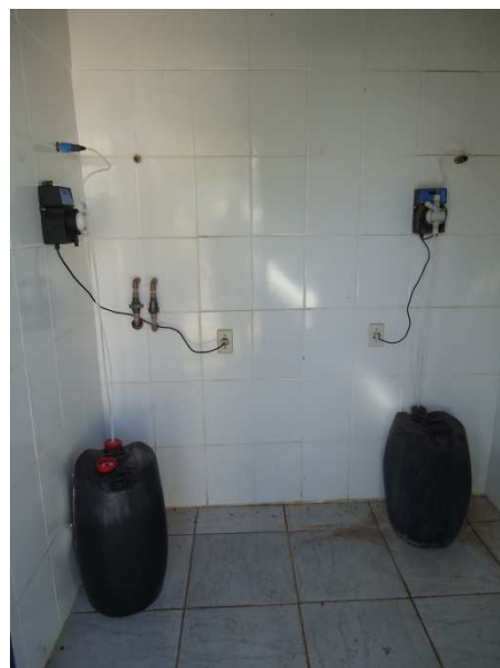
Foto 3.11- Unidade de Fluoretação e Cloração com bomba dosadora – Sistema Centro de Lazer – P4
