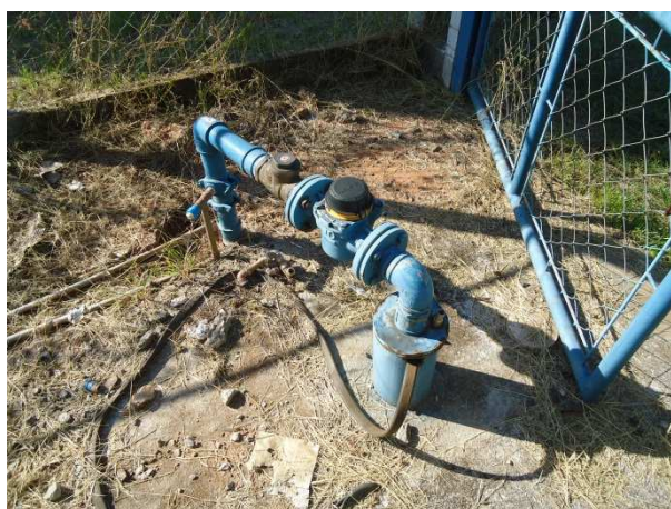
Foto 3.1 - Identificação do Poço: P-01
