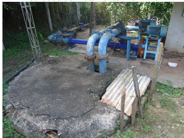
Foto 3.25 – EEE1 - Moto-bomba helicoidal marca GEREMIA
