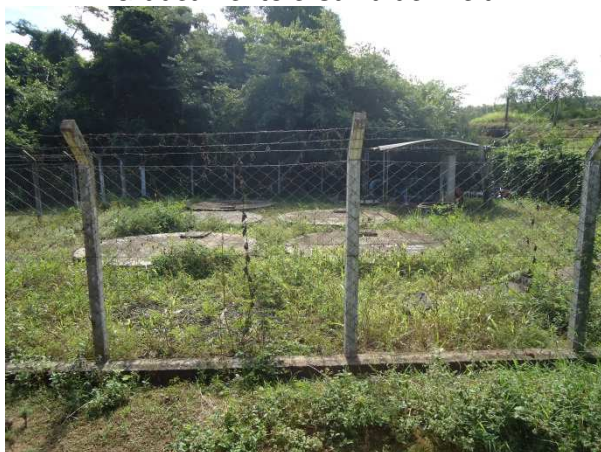
Foto 3.24 – EEE1 – Vista geral
