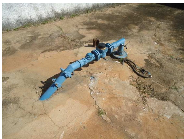
Foto 3.3 - Identificação do Poço: P-03
