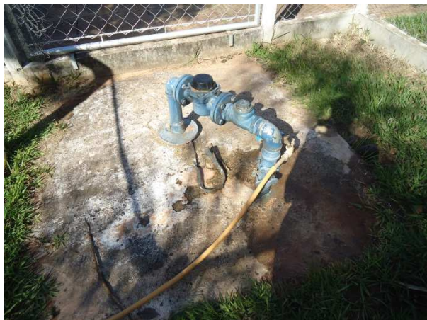
Foto 3.5 - Identificação do Poço: P-05
